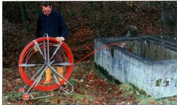
Einzug des Windenseiles in den Einstiegsschacht.
