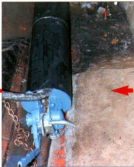
Einzug der anhängenden Rohre.
