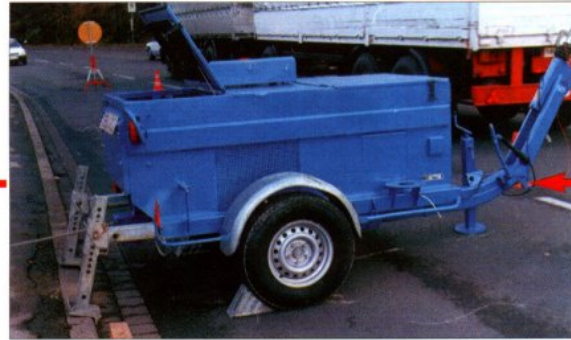
Die Winde führt den Grundocrack durch die Altleitung.
