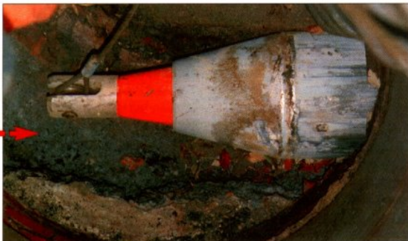
Der Grundocrack bei der Ankunft im Zielschacht.
